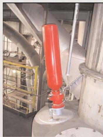
ANTIDET SUPPRESSOR è un sistema di sicurezza progettato per sopprimere chimicamente un'esplosione nella sua fase iniziale (per polveri Classe St1 e St2) ed evitarne gli effetti distruttivi.
