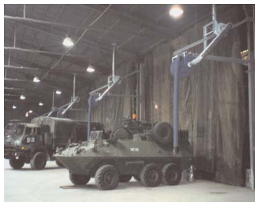
Installazione di arrotolatori serie 865 per l'aspirazione di gas di scarico da mezzi militari.
