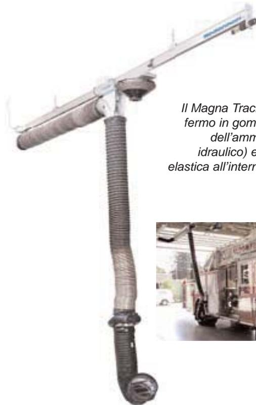
*Il Magna Track "S" ha un fermo in gomma (invece dell'ammortizzatore idraulico) e una corda elastica all'interno del tubo.*
