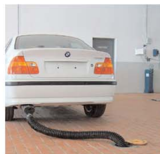
Sistema di aspirazione gas di scarico sottopavimento con speciali bocche di aspirazione per BMW.
