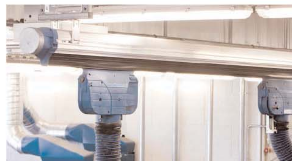
Sistemi di aspirazione con Canalina Blindotubo. Modello unico. Canalina e carrello con elevata capacità di aspirazione.
